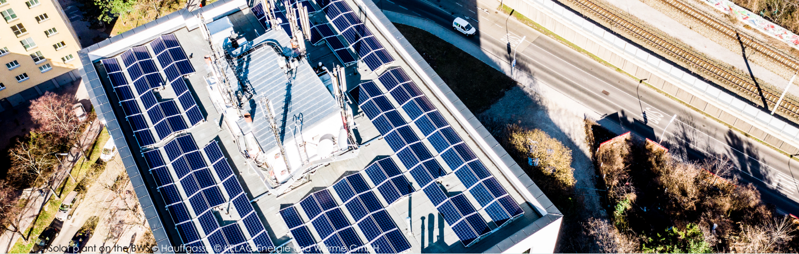
Solar plant on the BWSG Hauffgasse. © KELAG Energie und Wärme GmbH
